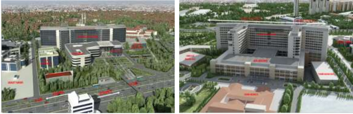
Şekil 2. Kartal Dr. Lütfi Kırdar Eğitim ve Araştırma Hastanesi Kuzeyve Güney cephe görünümü
