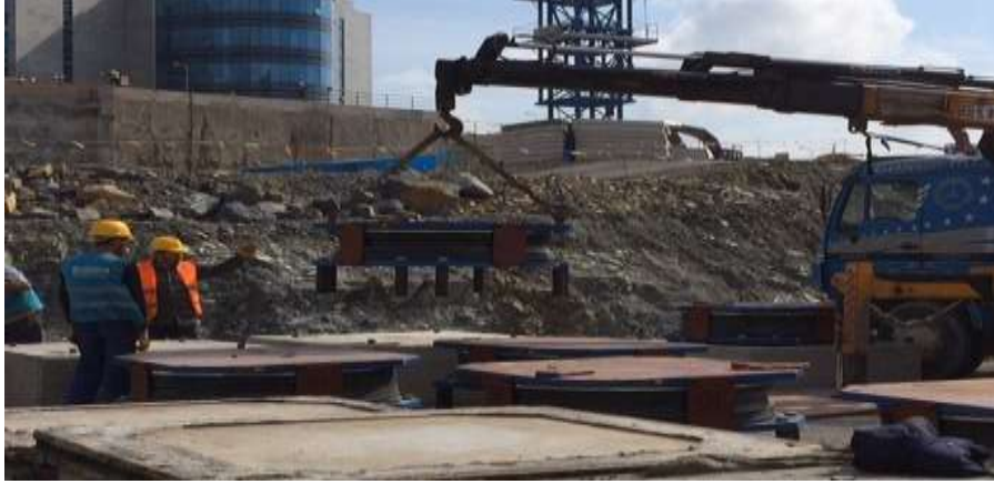
Şekil 3. Kartal Dr. Lütfi Kırdar Eğitim ve Araştırma Hastanesi Projesi sismik izolatör yerleştirilme anı
